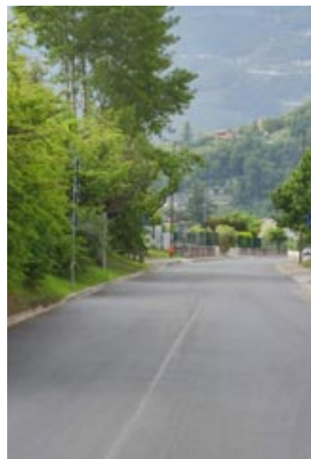
La nuova pavimentazione asfaltata di corso Vicenza (sopra) e di via Gozzer (sotto)
