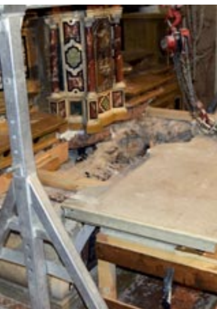
Un dettaglio nell'intervento di restauro che si concluderà prima di Natale
