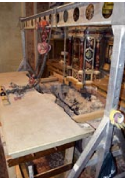
L'altare monumentale della Chiesa arcipretale di Borgo sottoposto a lavori di consolidamento della mensa
