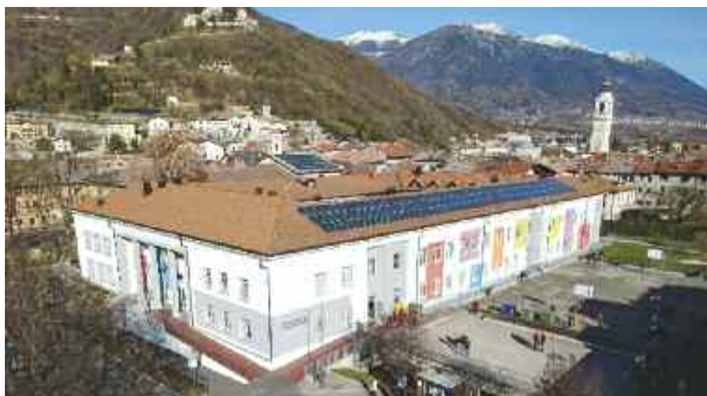
La Scuola media di Borgo vista dal drone: risalta la nuova bella tinteggiatura delle pareti esterne
